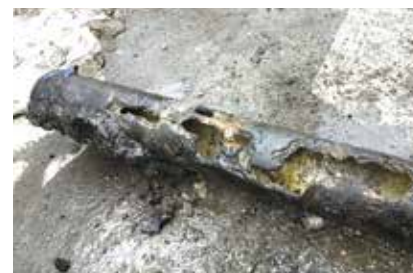
▲設置から44年が経過した水道管
