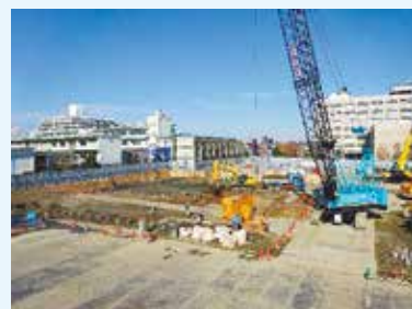
現在、校舎棟建設工事を進めています
