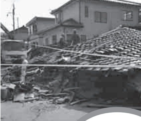
能登半島地震（平成19年：埼玉県建築士事務所協会提供）
