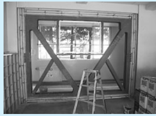
耐震補強工事
