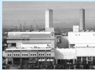
戸塚環境センター大規模改修
