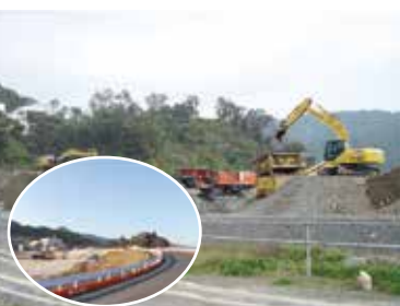
安全で安心な住宅地を整備するため新たな市街地は盛土工事を実施しています。また、地域間のアクセス向上のため道路整備も着々と進められています。
