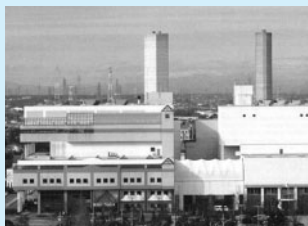
戸塚環境センター大規模改修
