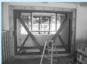
耐震補強工事
