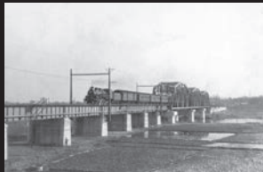
昭和3年ごろ 荒川鉄橋
