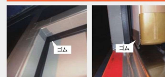
① 上枠及び召合わせに設置した気密ゴム ② 戸下部に設置した気密ゴム
