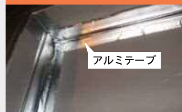
吊り引き戸の隙間へのアルミテープの貼付例
