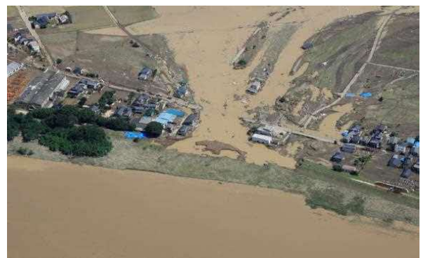
堤防決壊による家屋の流失(鬼怒川)
