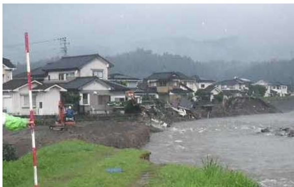
河岸侵食による家屋の倒壊(花月川)
