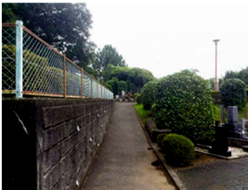
ユニバーサルデザインに配慮した園路への改修 (写真：安行霊園)
