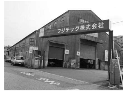
フジテック(株) (鋼材R曲げ加工)
