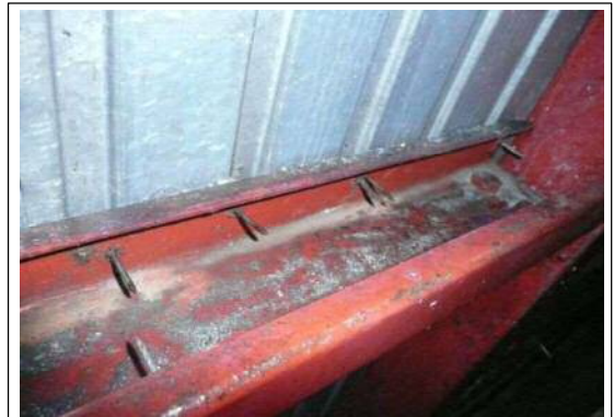
石綿除去細部の状況4 (写真⑧)
