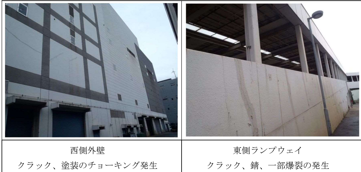
図 16 土木建築設備の状況（主に建築物）（抜粋）（令和3年3月精密機能検査報告書より引用）
