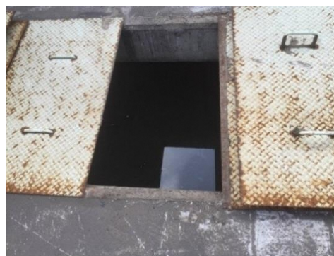
（左：ヤード周辺に排水溝を設置、右：油水分離槽の設置）
