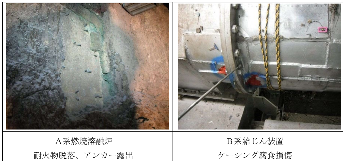
図 18-1 燃焼溶融設備の状況（抜粋）（令和3年3月精密機能検査報告書より引用）
