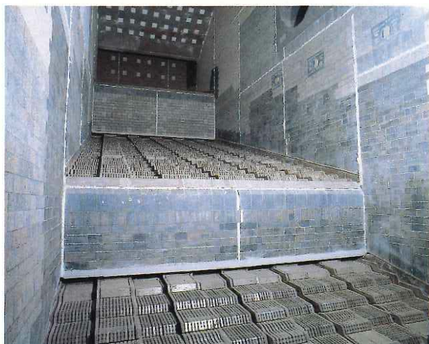
■ 焼却炉内部 ■ 蒸気タービン発電機
