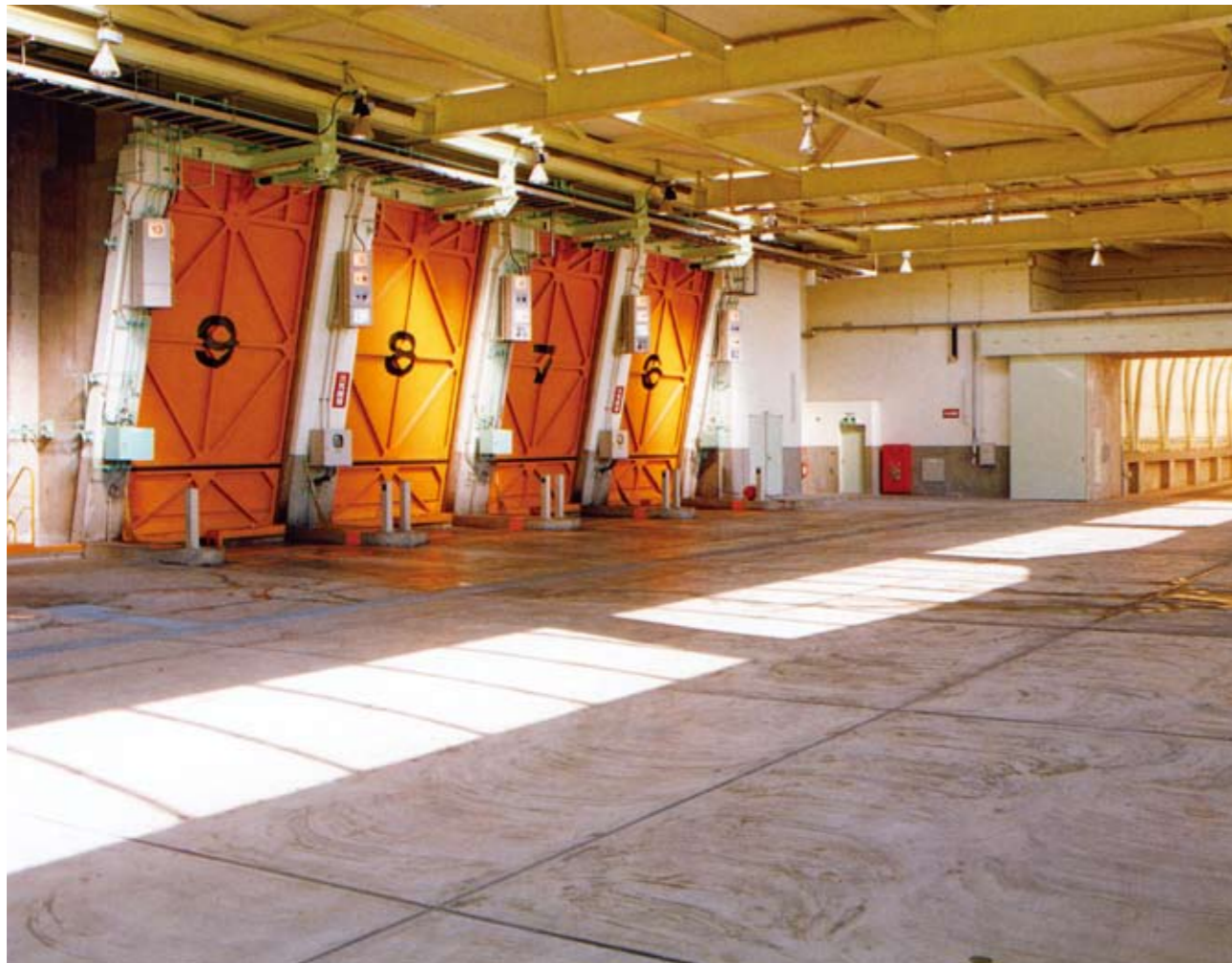
▲投入ステージ 計量された「ごみ」は、ここからごみピットへ投入されます。 Platform Measured refuse is thrown into the refuse pit from here.
