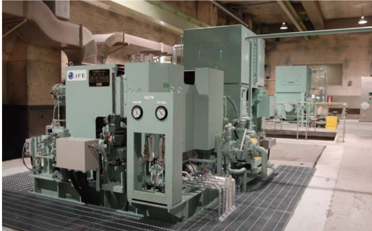
▲蒸気タービン発電機「ごみ」の焼却により発生する熱エネルギーの有効利用として、ボイラで発生した蒸気を用いて、発電(4,200kW)を行い、センター内で使用します。また、余剰電力は電力会社に売却されます。
