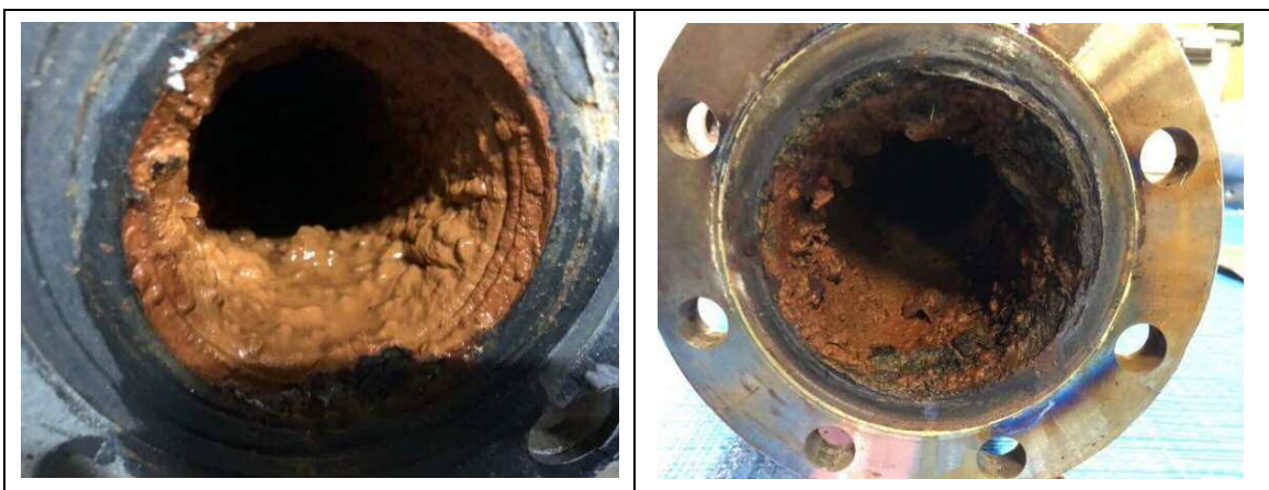
図 1-5 サンアール朝日の4階機械室内余熱配管の状況
