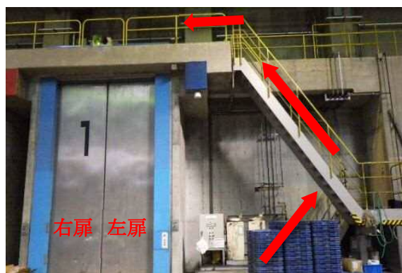
写真 19. 投入扉上部設置の非常ドアコックまでの経路
