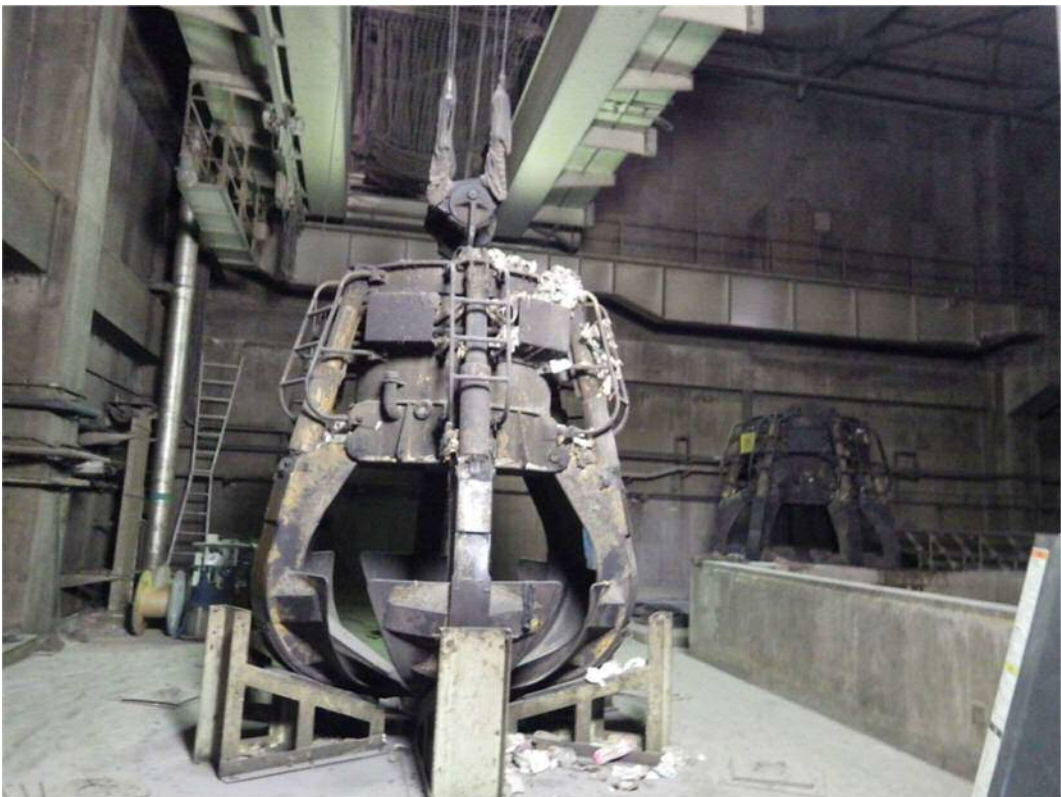
写真3. No.2 ごみクレーン
