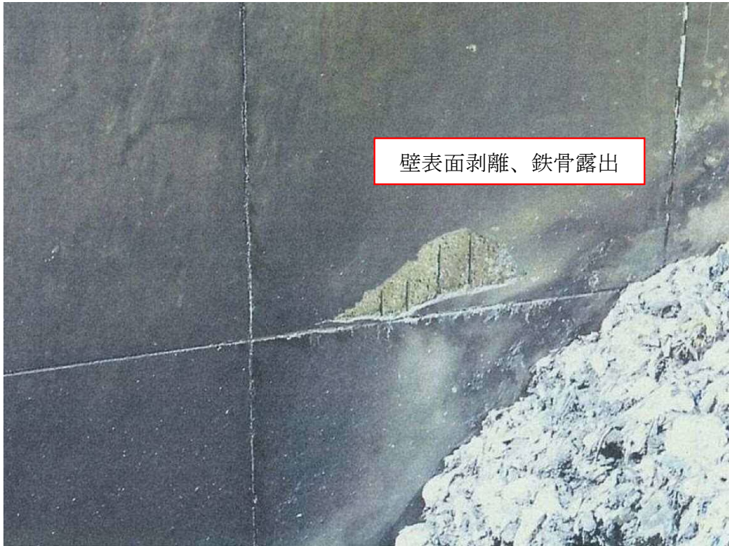
写真 6. ごみピット壁
