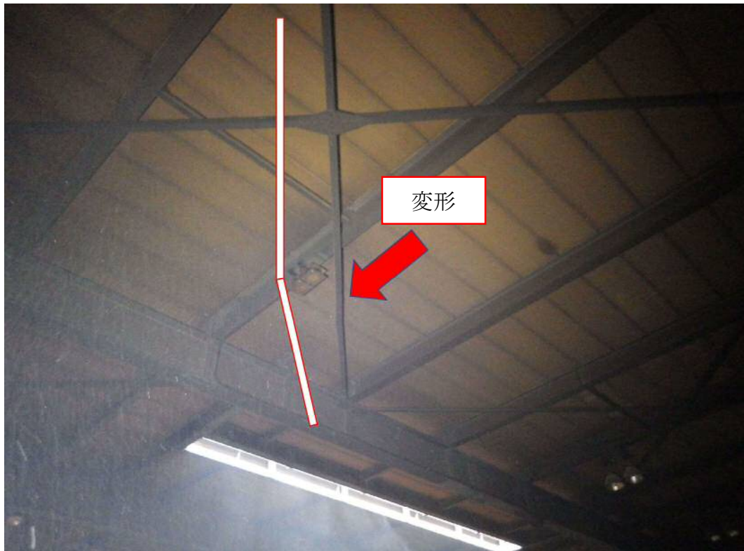
写真 7. 屋根鉄骨水平ブレース
